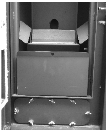
Figura 53 - Limpeza do interior da salamandra
