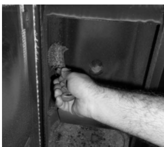
Figura 50 - Limpeza do interior da salamandra a água
