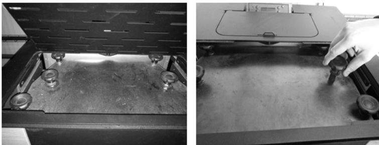
Figura 46 - Limpeza dos turbuladores
