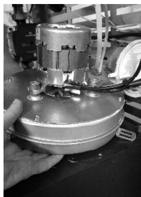
Figura 58 - a) Retirar os parafusos; b) Retirar extractor
