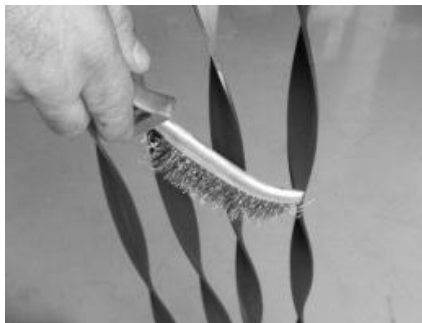
Figura 57 - Limpeza dos canais de passagem de ar e turbuladores
